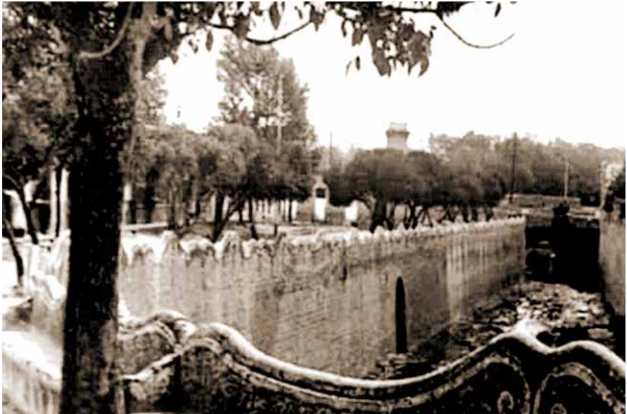
Antigua imagen del río San Francisco. Se nota en el muro de contención la boca de la galería subterránea y al fondo el edificio del cuartel de los "Rurales". Circa 1909, anónimo.
