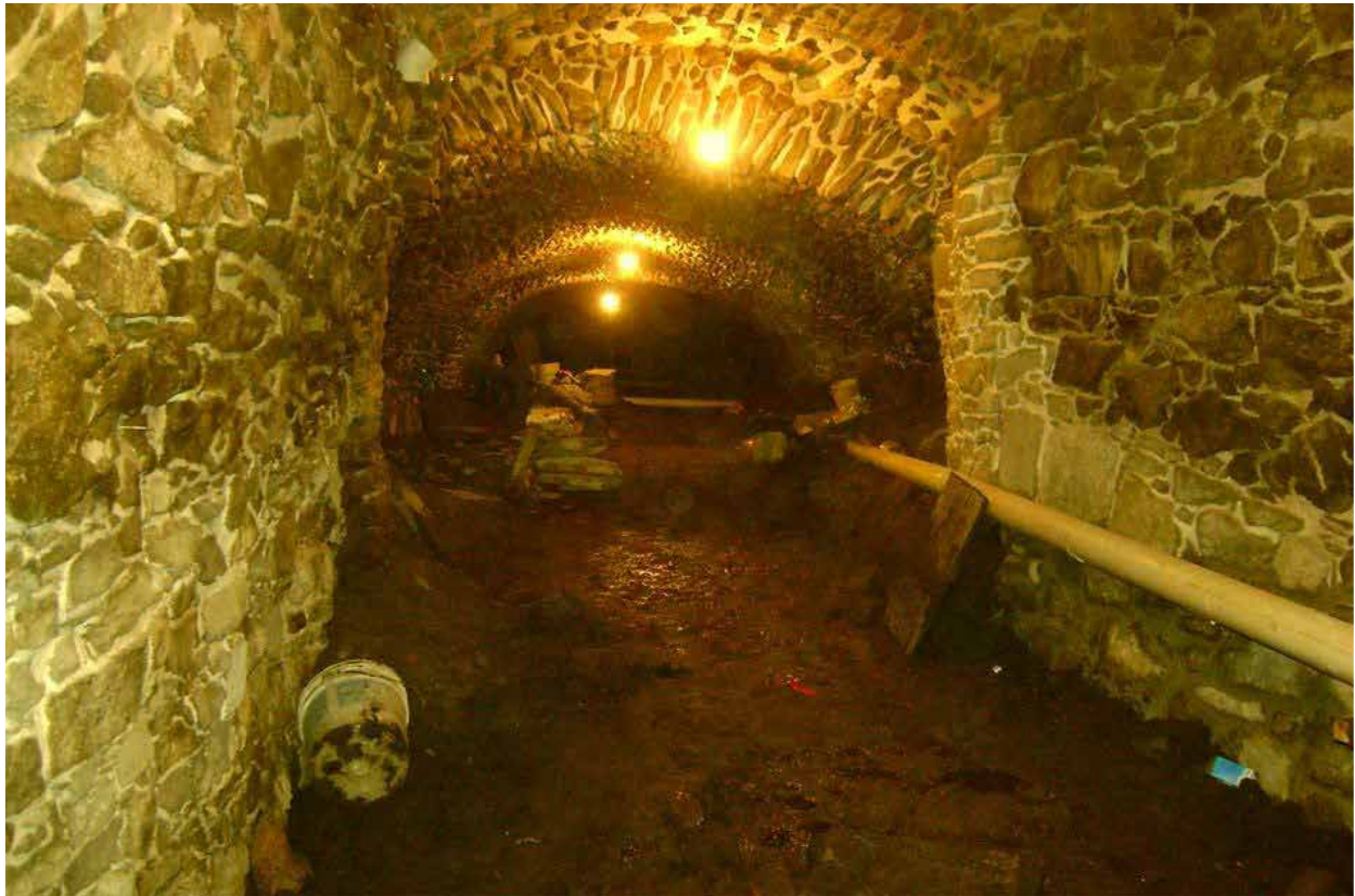
Interior del polvorín de Xanenetla, que funcionó como sistema de desagüe y como escondite para el cuartel de los "Rurales". Fotografía de Mauricio Banenelli Pérez, 2014.
