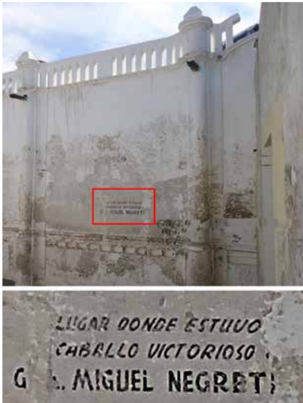
Fig. 12. Detalle de muro oeste del antiguo templo.
