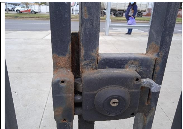
Fotografía N°: 11 Materia : Corrosión en elementos metálicos.
