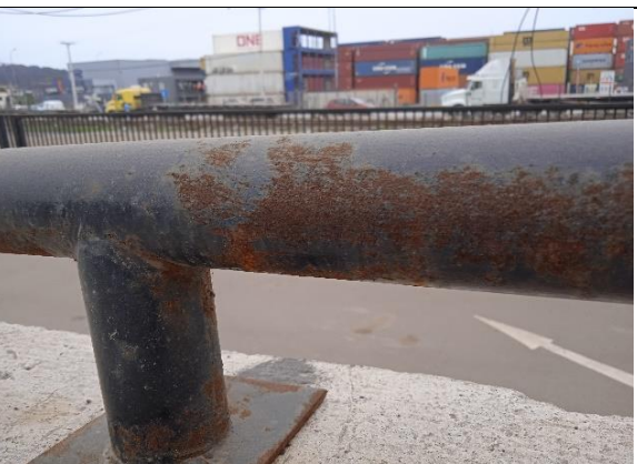
Fotografía N°: 12 Materia: Corrosión en elementos metálicos.
