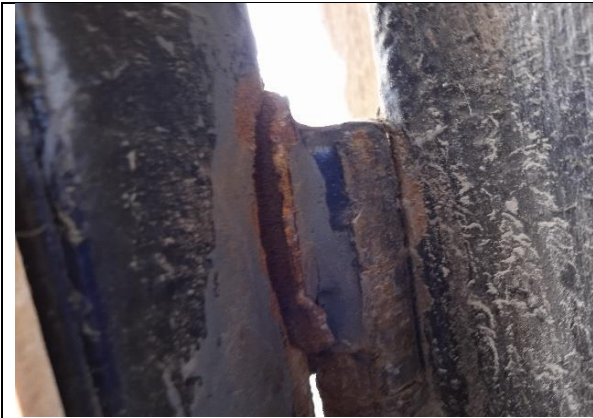
Fotografía N°: 9 Materia : Corrosión en elementos metálicos.
