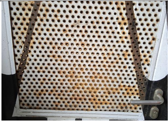
Fotografía N°: 10 Materia : Corrosión en elementos metálicos.
